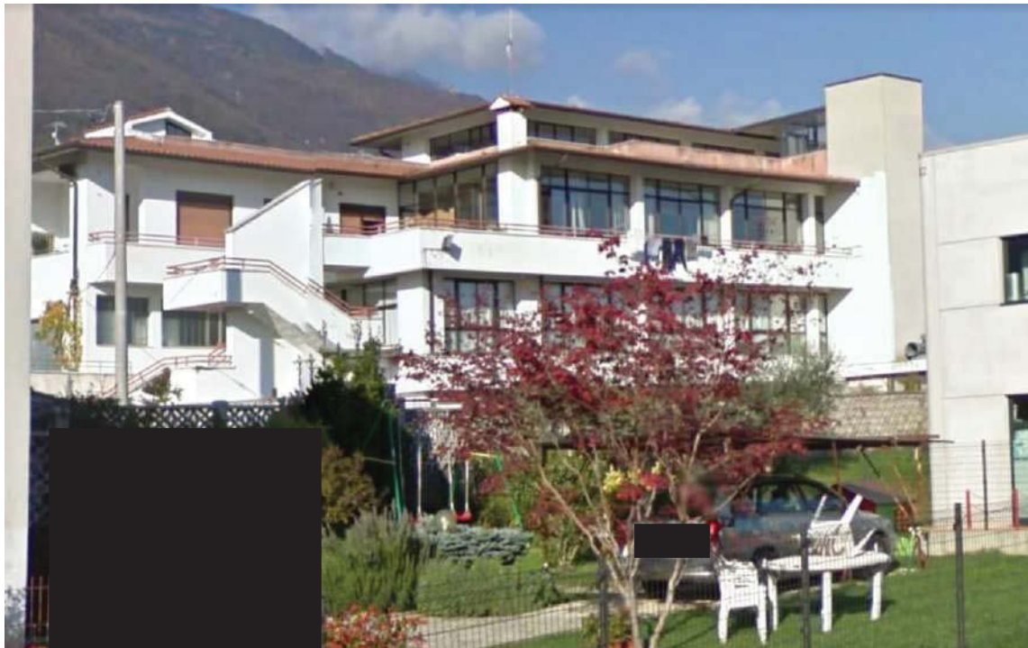
FOTO D Google – VISTA LATERALE DA VIA CALLESELLO
