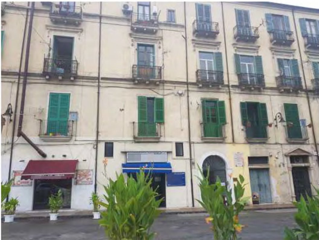
Fotografia 4: Ingresso Magazzino (Corso Plebiscito 22)
