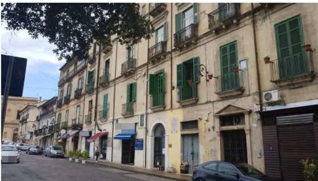
Fotografia 2: Vista Immobile da lato strada
