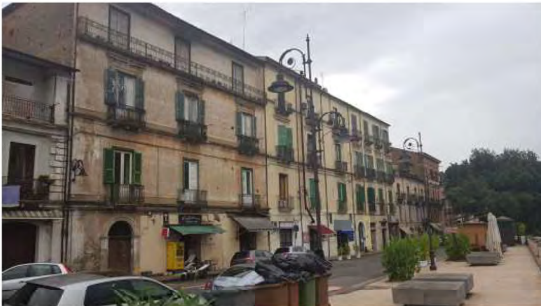
Fotografia 1: Vista immobile da affaccio panoramico
